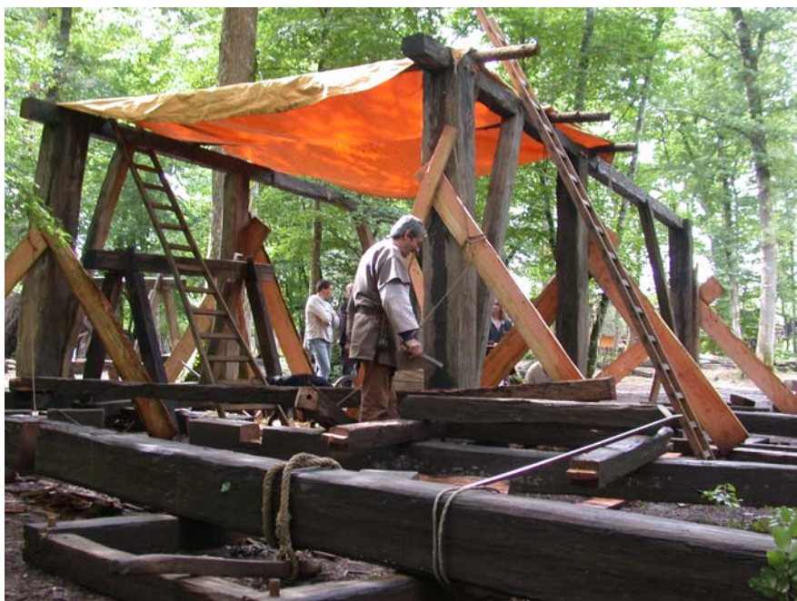
Les deux pans de l'atelier viennent d'être levés © Guédelon
