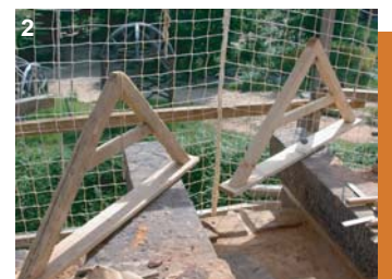
corbeaux de la latrine (tour maîtresse)
