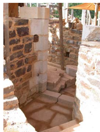
palier donnant accès au chemin de ronde
