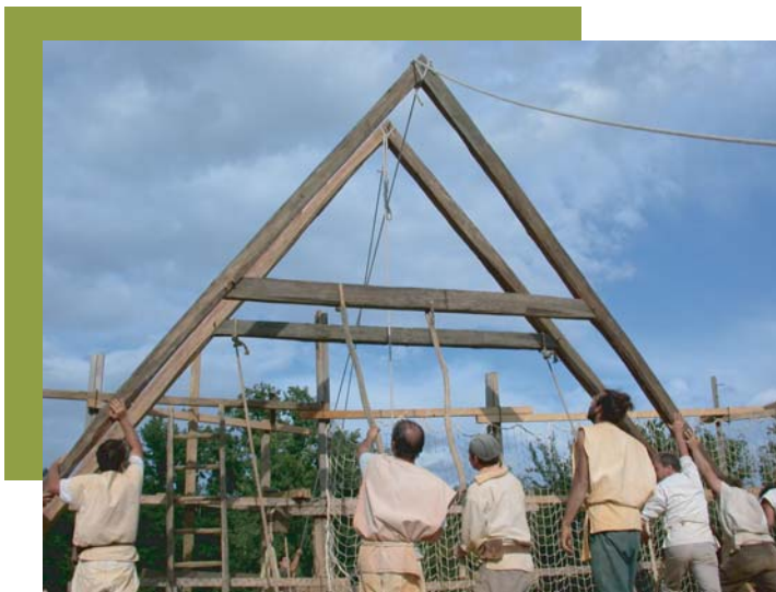
La 2 ème ferme est levée
