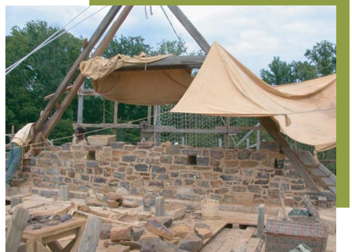
Maçonnerie du mur pignon (les trous apparents dans la maçonnerie sont des trous de boulins qui permettront d'ancrer les échafaudages)
