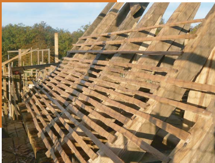
Le lattis en cours de pose
