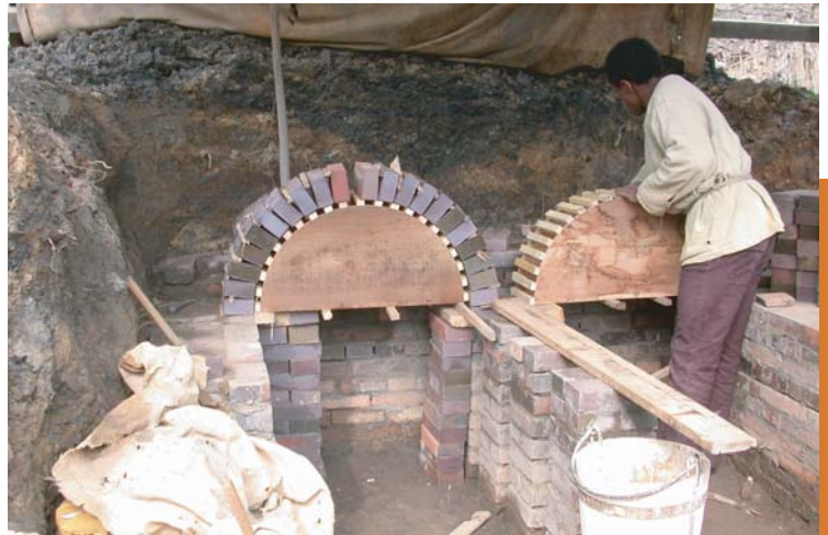
Construction du nouveau four à tuiles
