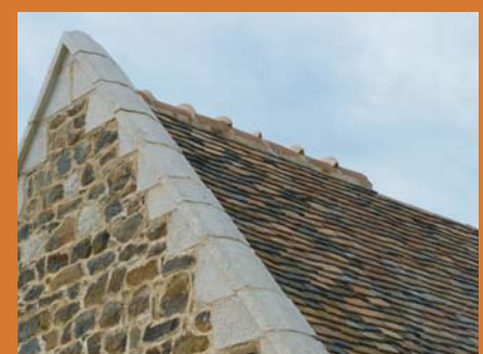
chaperons posés en 2008 sur l'autre pignon
