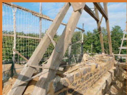
maçonnerie du mur pignon Ouest
