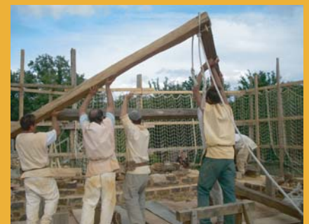
Levage d'une ferme de charpente
