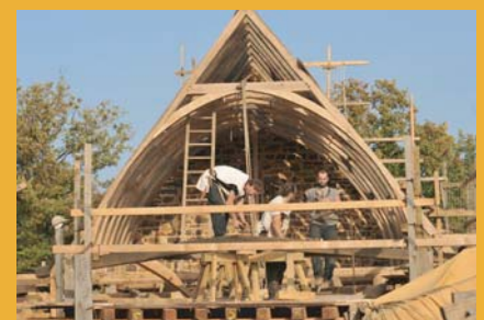
Pose des 9 fermes de charpente
