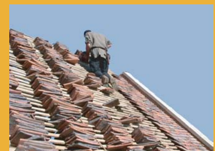
Pose des tuiles sur le toit
