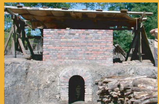
Le nouveau four à tuiles est terminé. 3 000 tuiles vont être cuites prochainement.
