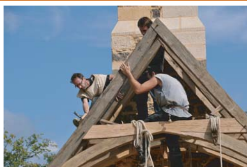
Les charpentiers procèdent aux ultimes assemblages.
