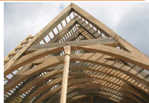
Le lattis est cloué ; les tuiles vont être posées.
