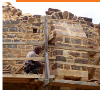
Vue extérieure de la latrine
