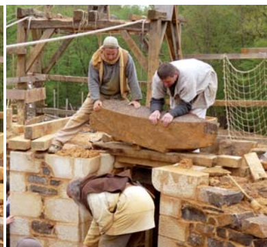
Les coussinets sont enduits de mortier.
