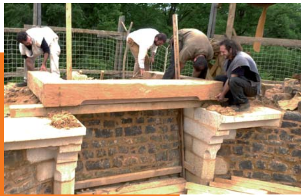
Le linteau de la cheminée en cours de pose
