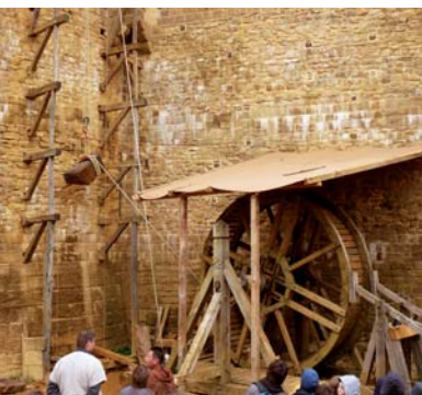
Le linteau est hissé à l'aide de la cage à écureuil
