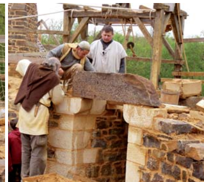
Enfin, après réglage, il est scellé sur les coussinets.
