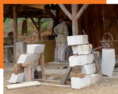
Les pierres de chaînage de la hotte de la cheminée
