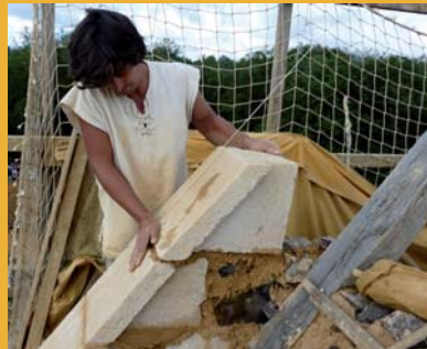
Les maçons posent les derniers chaperons sur le mur pignon.
