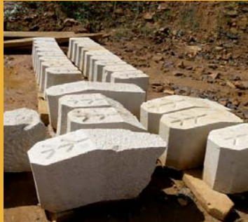
Les tailleurs de pierre ont taillé la plupart des voussoirs et l'intégralité des sommiers.
