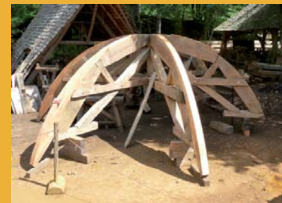
Les charpentiers ont réalisé le cintre en bois qui va soutenir les maçonneries de la voûte durant sa construction.
