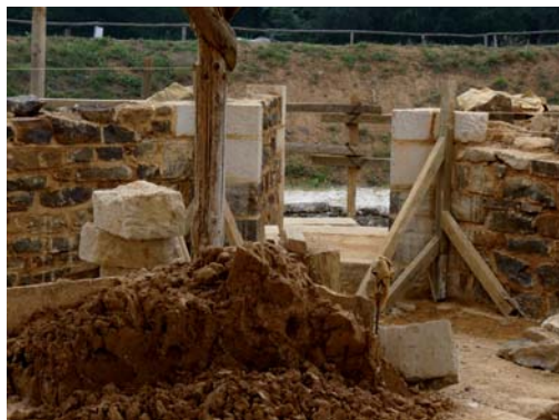
Porte d'entrée de la tour d'angle
