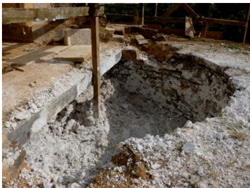
L'intérieur de la tour d'angle est rempli de chaux
