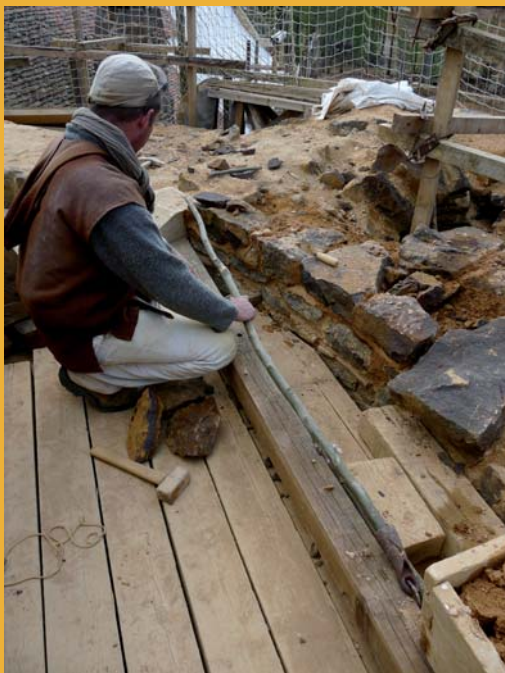
Début des maçonneries sur le 1 er arc formeret.
