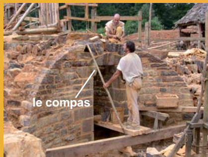
Le maçon vérifie l'arrondi de son arc (voûte de la cave de la tour maîtresse réalisée en 2003)
