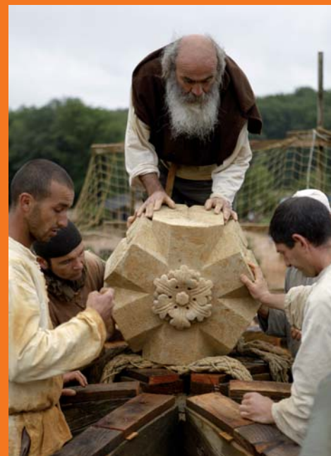
La clé est déplacée sur le cintre
