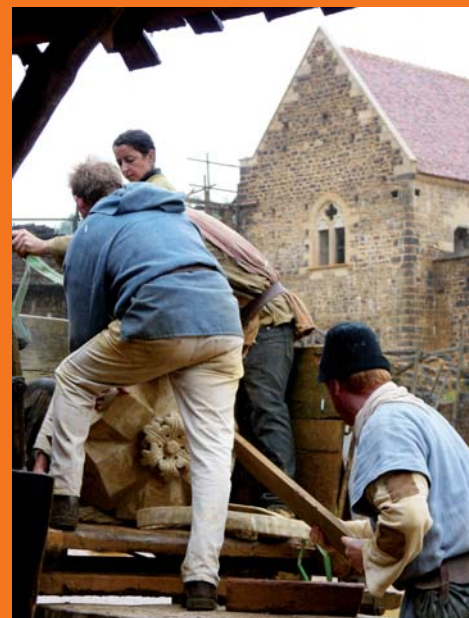
La clé est montée dans le tombereau
