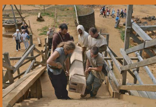
Le linteau de la cheminée est transporté dans la grande salle
