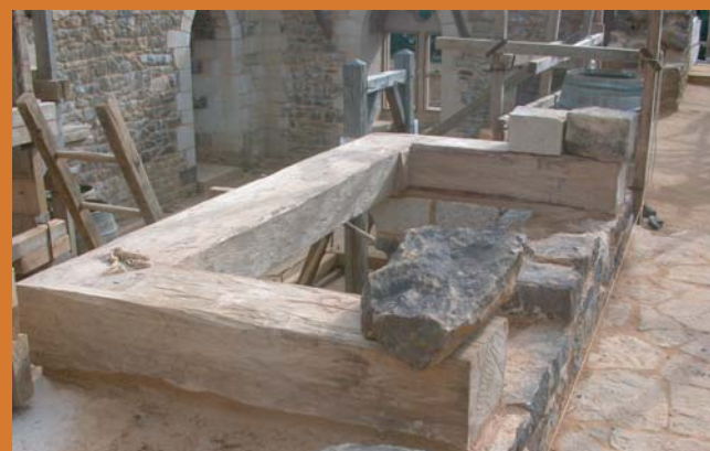
Le linteau est assemblé sur les tablettes
