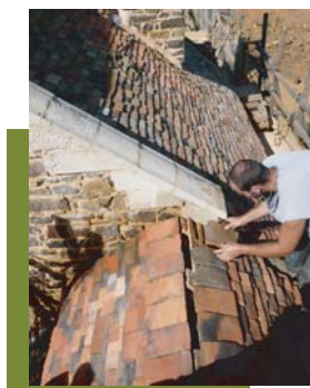
Couverture de la galerie
