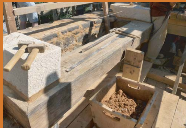
Les montants en calcaire de la hotte ont commencé à être posés
