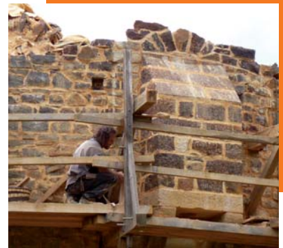
Vue extérieure de la latrine
