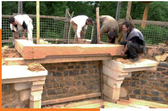
Le linteau de la cheminée en cours de pose
