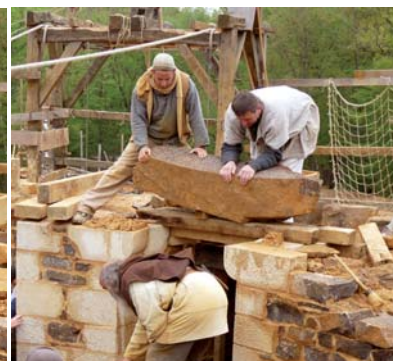
Les coussinets sont enduits de mortier.
