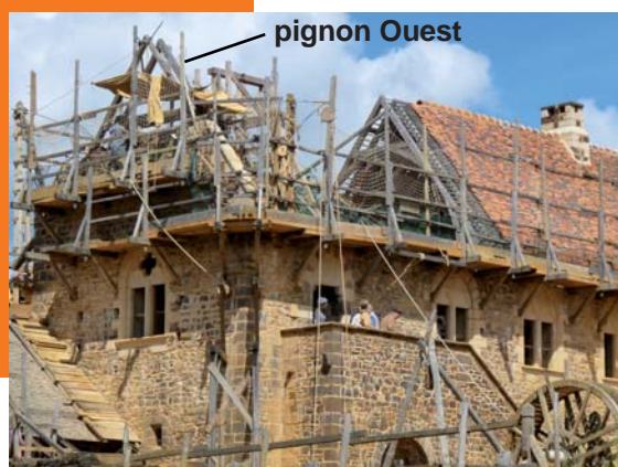
façade Sud du logis
