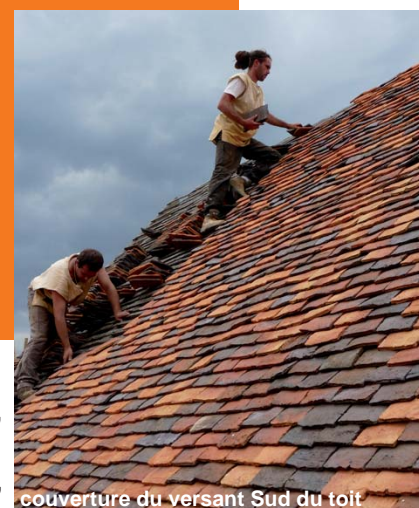
couverture du versant Sud du toit
