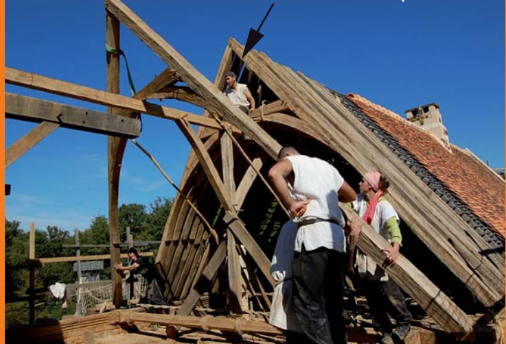
Un ouvrier décolle la ferme sur la potence
