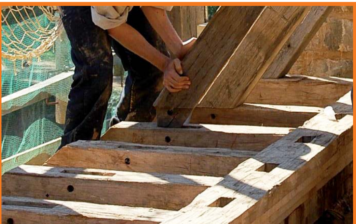
Le charpentier fait entrer l'extrémité du chevron dans le blochet. Une cheville viendra assembler définitivement les 2 pièces de bois.
