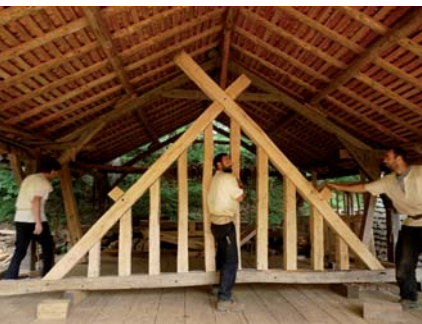
Une des fermes à pans de bois du nouvel atelier pédagogique.
