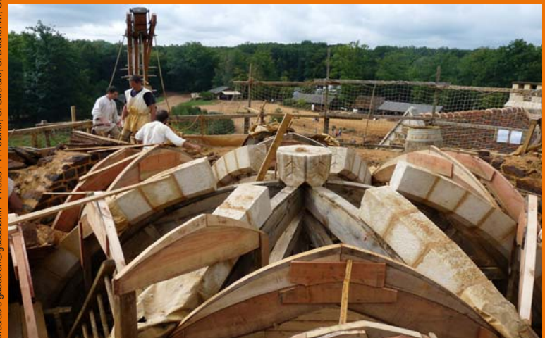
19 août 2011 : la majorité des voussoirs est maçonnée. Seules les contre-clés restent à poser.
