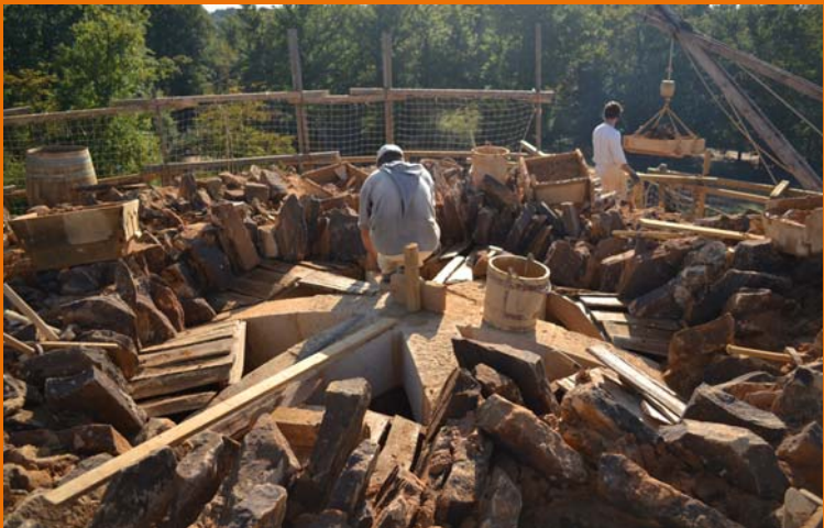
23 septembre 2011 : les dalles de grès sont maçonnées sur les couchis pour former les voûtains.
