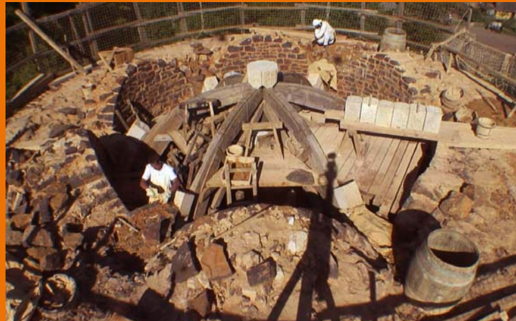
1er août 2011 : tous les arcs formerets sont terminés et la clef est posée au sommet du cintre.
