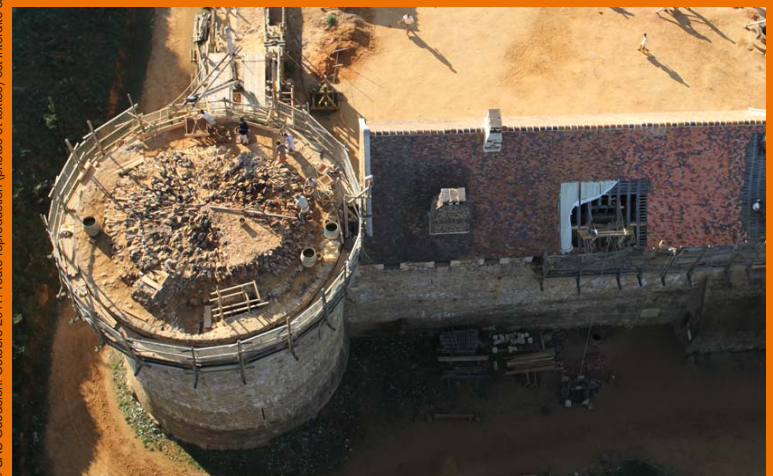
14 octobre 2011 : le remplissage est terminé et la voûte est décoffrée.
