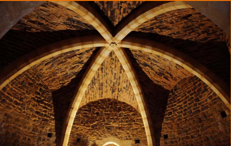
16 octobre 2011 : les échafaudages sont démontés pour laisser place à la splendeur de la voûte.
