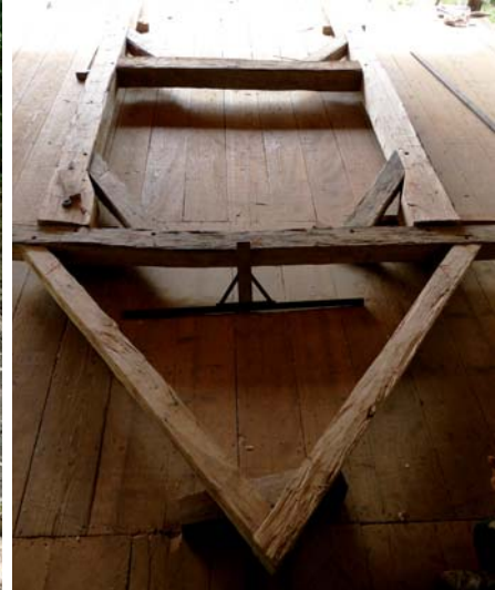
Une des fermes assemblée sur le plancher d'épures
