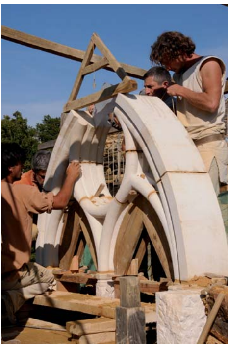
Vérification du niveau à l'aide de l'archipendule
