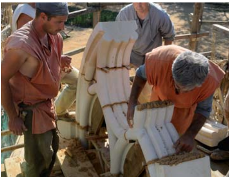
Maçonnerie de l'oculus de la fenêtre
