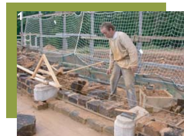
1 ères pierres de la cheminée
