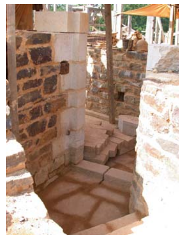
palier donnant accès au chemin de ronde
