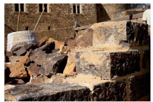
les trois premiers rangs de la tour de gauche ont commencé à être maçonnes
