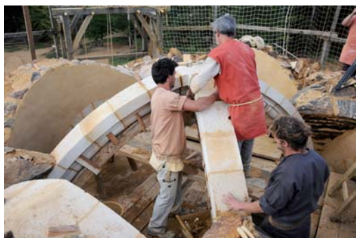
pose de la dernière contre-clé de la voûte
